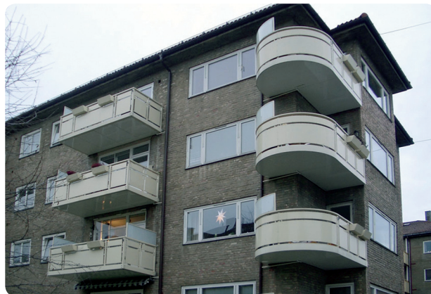
Bygning fra 1930-årene som har fått nye balkonger. Med noe økt størrelse og nye materialer er de blitt mer anvendelige samtidig som opprinnelig karakter opprettholdes. Foto: [721]
